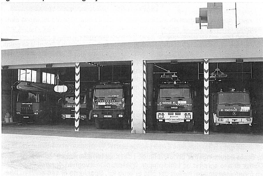
Hovedgaragen på brandstationen i Benidorm.
